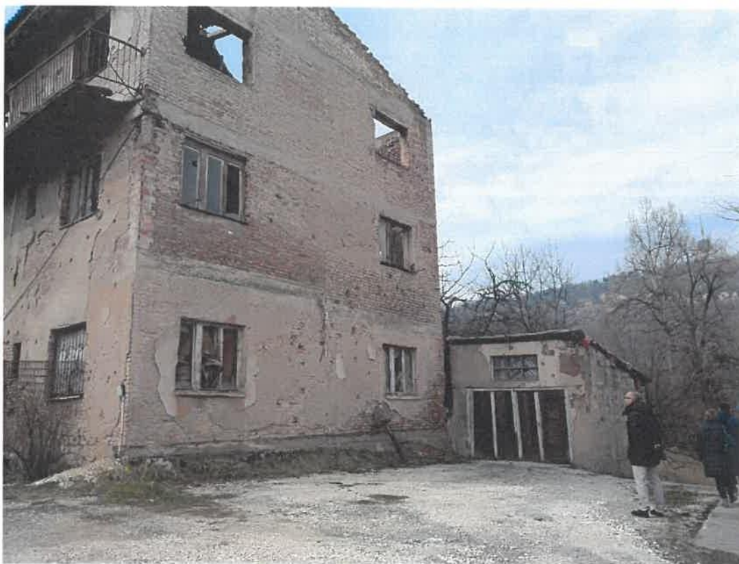
„Objekat C“ - „Strelišće“, planiran za rušenje ili moguću ponovnu izgradnju
