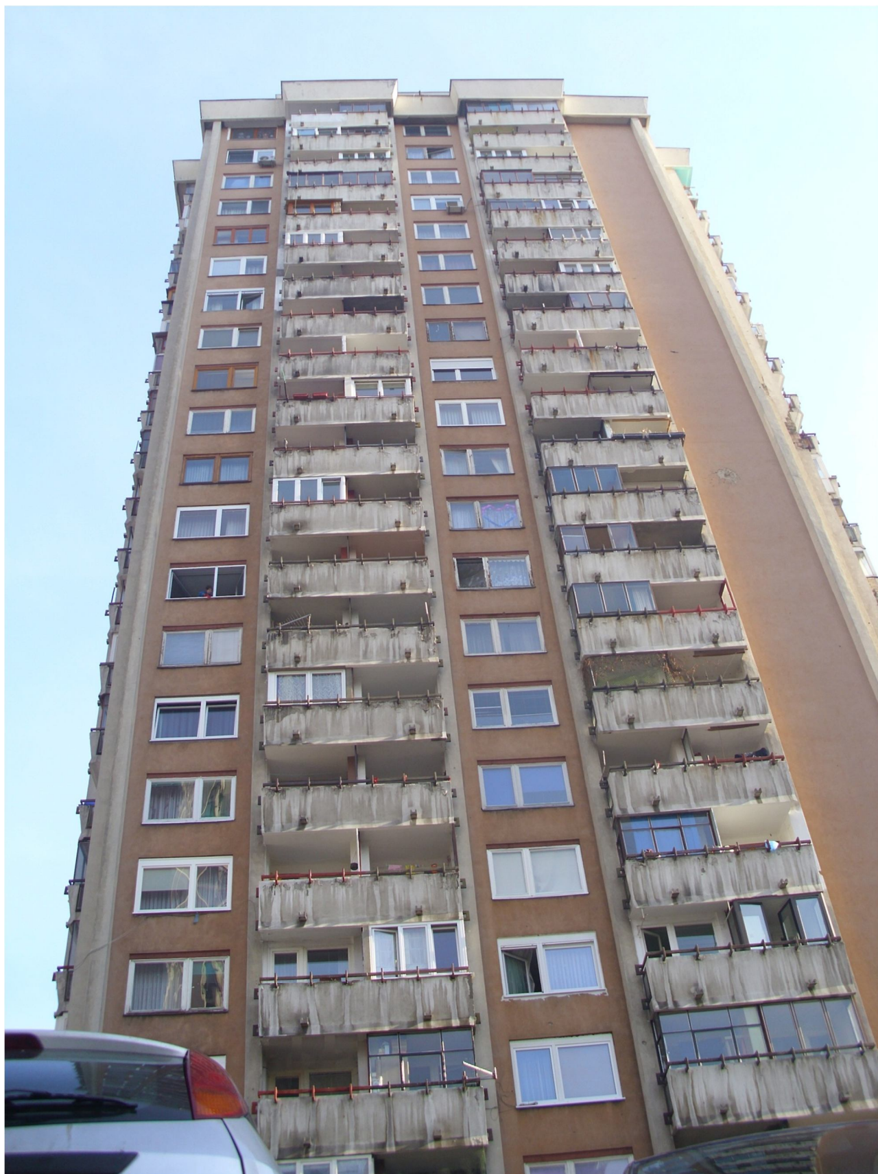
Slika 8. Određen broj visokih objekata, sa nemogućnošću prilaza vatrogasnim vozilima i nemogućnošću djelovanja na visokim spratovima
